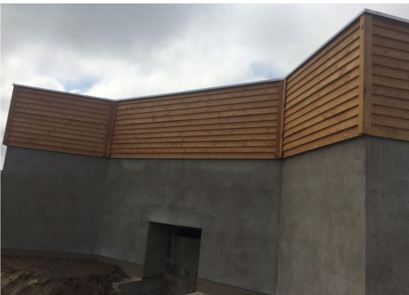
Abbildung 28 Winter Fledermausersatzquartier - Umgebauter Wasserspeicher mit Flügelwand
